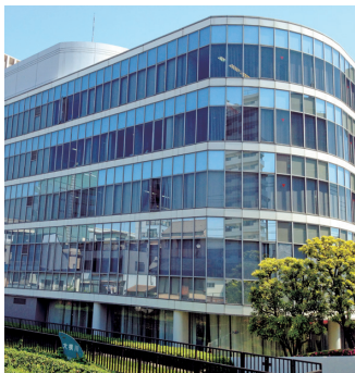
●名古屋木場ビル 東京都江東区木場1丁目
